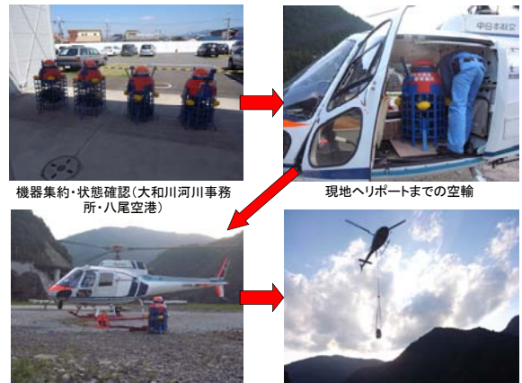
現地ヘリポートでの荷吊り
