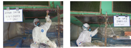
2回目塗付け作業0.5kg/m 2
