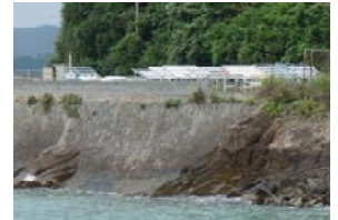
沖縄県 大宜味村「沖縄建設材料耐久性試験施設」
