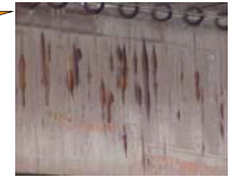
腐食環境の区分: 海岸線から1.5km
