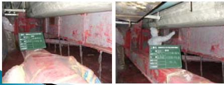
桁部 1回目はく離剤塗後
