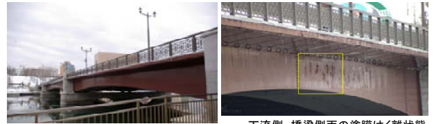
上流側の橋梁側面全景
