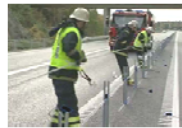
30m区間を開放するために3本のワイヤーロープをポストから外し、地面に置く。
