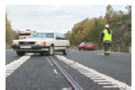
事故に対応するため、緊急車両にワイヤーロープ上を通過させる。
