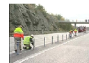
ポスト入れ、ワイヤーロープを持ち上げて戻す。再び緊張させる必要はない。
