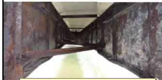
橋梁内部の激しい塩害劣化
