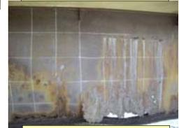
桁端部の破断、座屈
