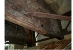
桁端部の腐食破断
