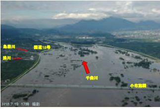
立ヶ花秩苅部 (H18.7豪雨の出水状況)
