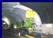
①施工写真
