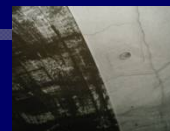
2. ケレン・プライマー塗布
