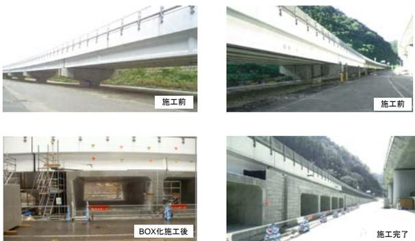
**BOX化施工による塩害橋梁の抜本対策**
