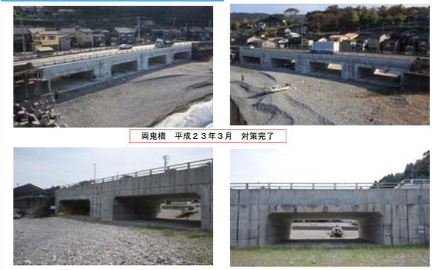
**BOX化施工による塩害橋梁の抜本対策**
