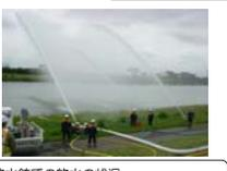
放水銃での放水の状況(排水ポンプ1台で十分な水量の確保が可能)
