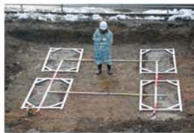
杭頭確認状況 (施工後)
