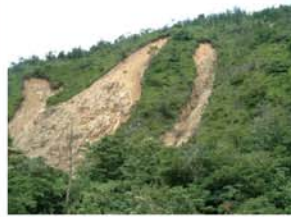
①斜面崩壊
