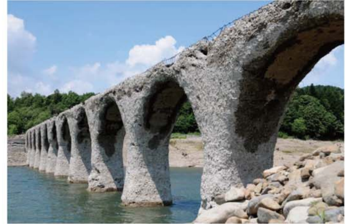
糠平ダム(1956年)に沈む橋梁
