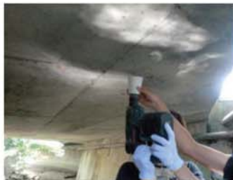
コンクリート粉末の採取状況
