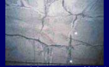
コールドジョイントとひび割れとの 組合せでブロック化
