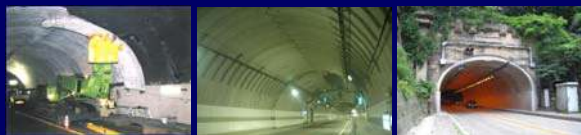
①施工写真 ②完成写真 ③完成写真
