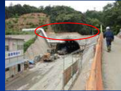
トンネル坑口
