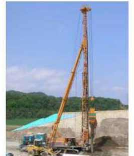
GCCP工法の施工状況
