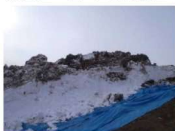
仮置き土の雪による保温養生
