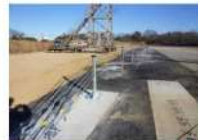
防護柵設置状況(端末)
