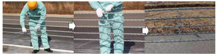
ロープ連結材の取り付け時間は1カ所当たり約1分
