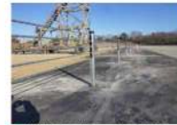
防護柵設置状況(中間支柱)
