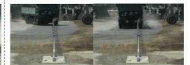
大型車の防護柵衝突後の軌跡(2014年3月)
