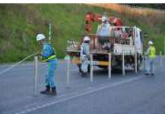
ワイヤロープの設置
