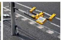
張力計で所定の張力を確認
