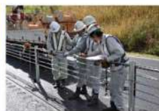
中間ターンバックルの取り付け
