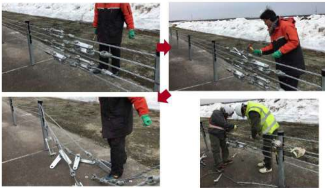
1人が約1分でワイヤロープの取り外しを完了し、復旧は2人で約10分
