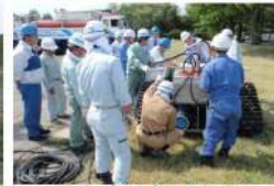
排水ポンプ搭載作業
