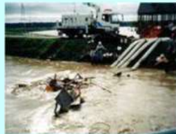
排水ポンプ車による排水作業 (出典：国土交通省北海道開発局HP)
