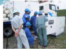
操作盤接続作業
