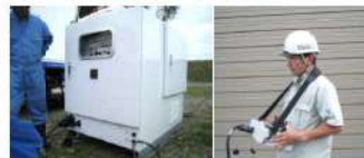
操作盤及びコントローラ
