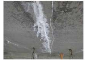
析出物があると、注入出来ないとの理由でUカット充填工法を採用する事例も多い
