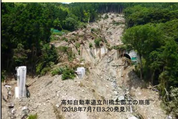
高知自動車道立川橋上部工の崩落
