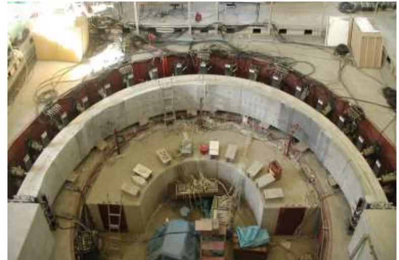
部分薄肉化PCL版を用いたトンネル補強工法
