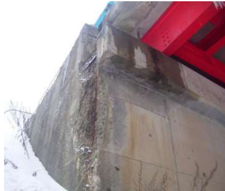
凍害・塩害の複合作用を受けた北海道内のコンクリート部材の一例
