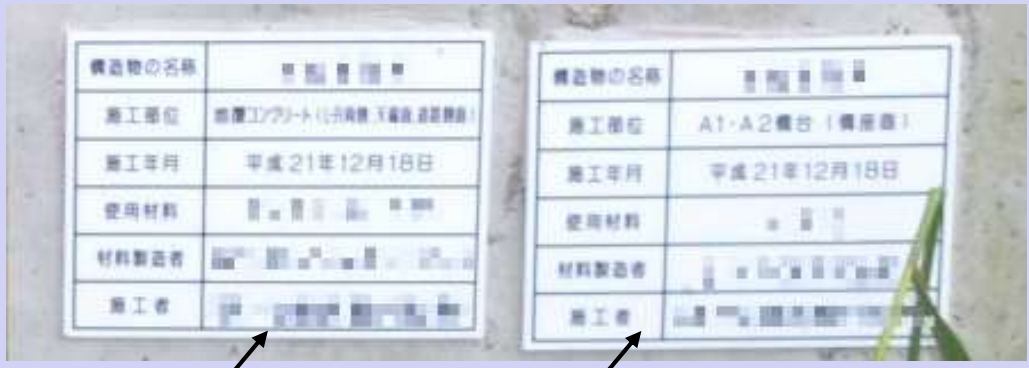
地覆にシラン、橋座面にけい酸塩(2枚にわけて貼り付け)
