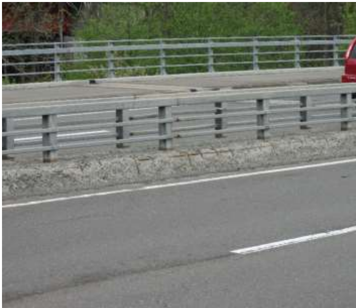
凍害・塩害の複合作用を受けた北海道内のコンクリート部材の一例
