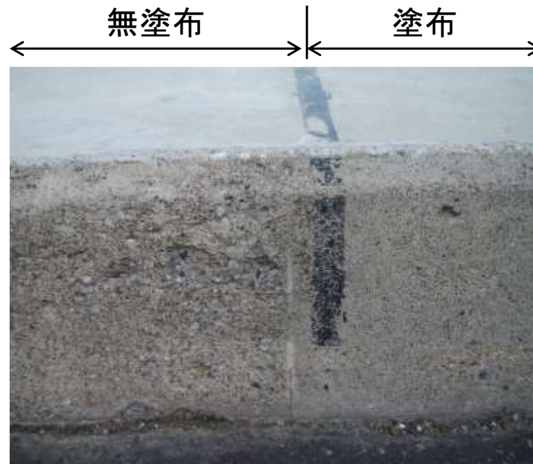
14年経過した道路橋地覆 この橋は直線橋で、地覆に水は集まりにくい
