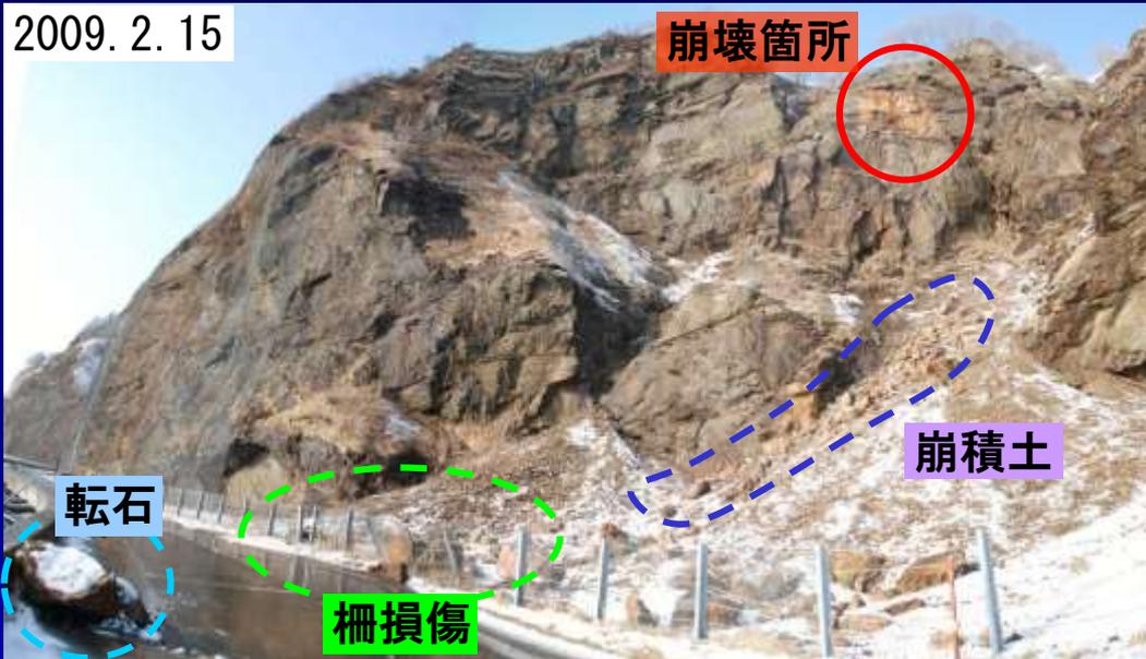
道路上の転石や構造物損傷などの**明確な変化**があれば、崩壊**発生源**を意識して探すだろうが、**実際は複数箇所**で**変状**が発生しているかもしれない。
