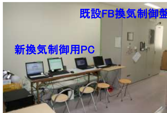
新換気制御の状況【電気室内】
