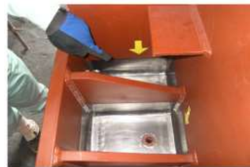
チタン箱施工状況
