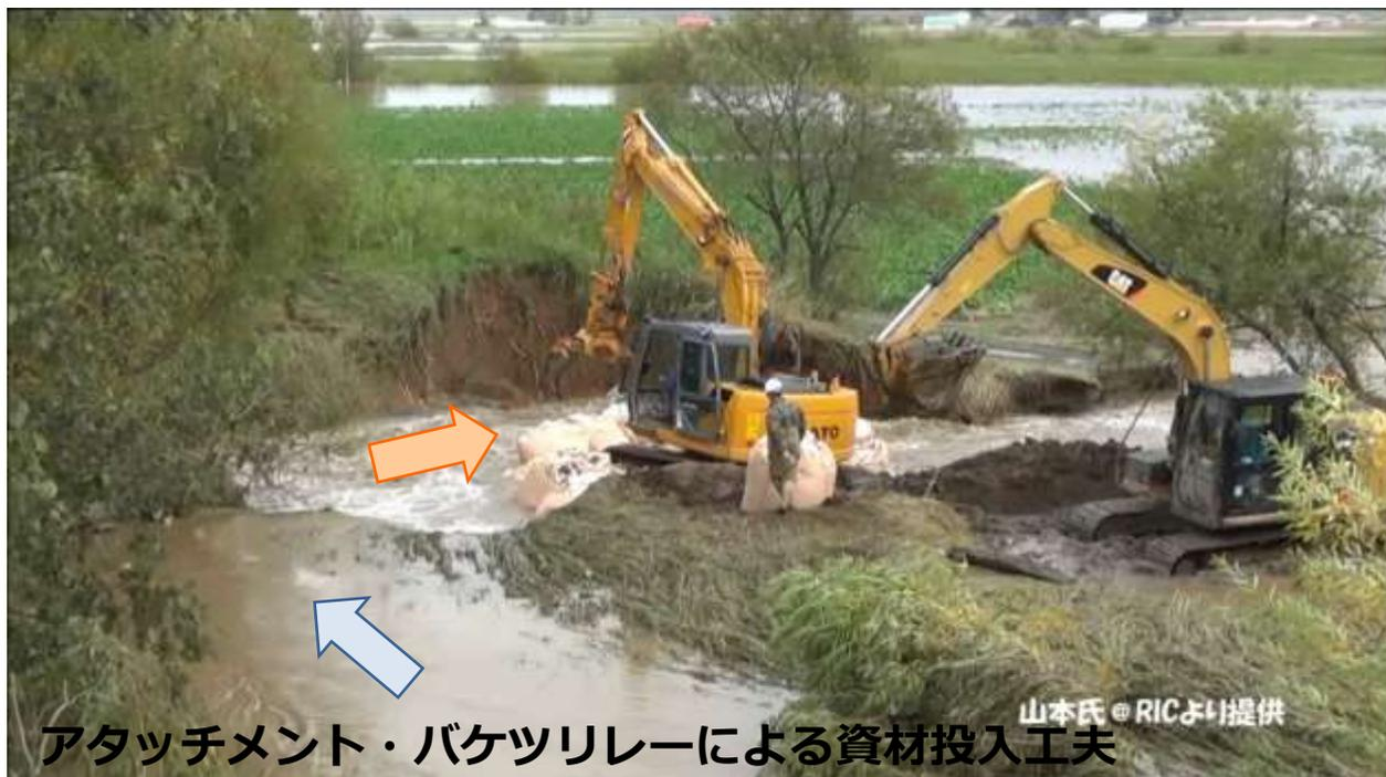
アタッチメント・バケツリレーによる資材投入工夫
