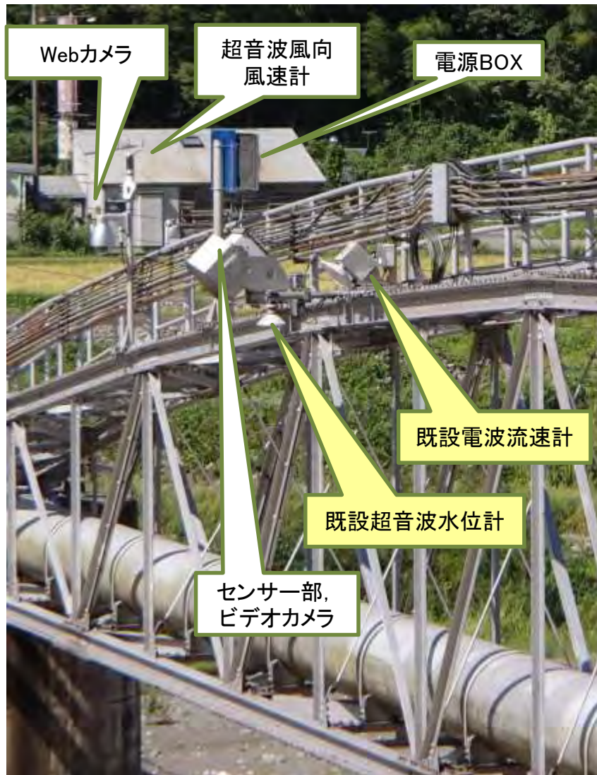
右岸(局舎近く)から撮影
