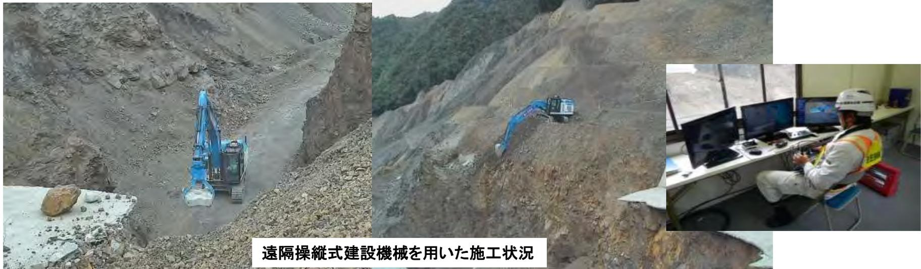
遠隔操縦式建設機械を用いた施工状況
