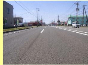
平成14年に施工した「機能性SMA」の損傷状況を目視によって確認したが、目立った損傷は発生しておらず、供用後10年経過した現在でも健全な状態を保っていることが確認された。
