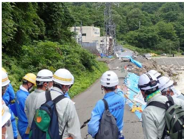
緊急的な現地調査
