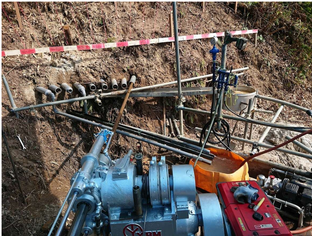
応急横ボーリング工の施工
