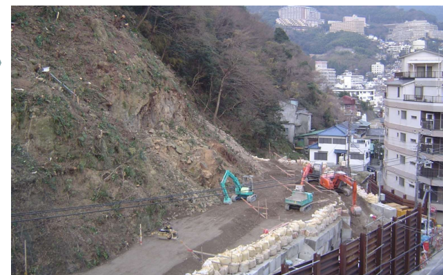
応急対策工事
