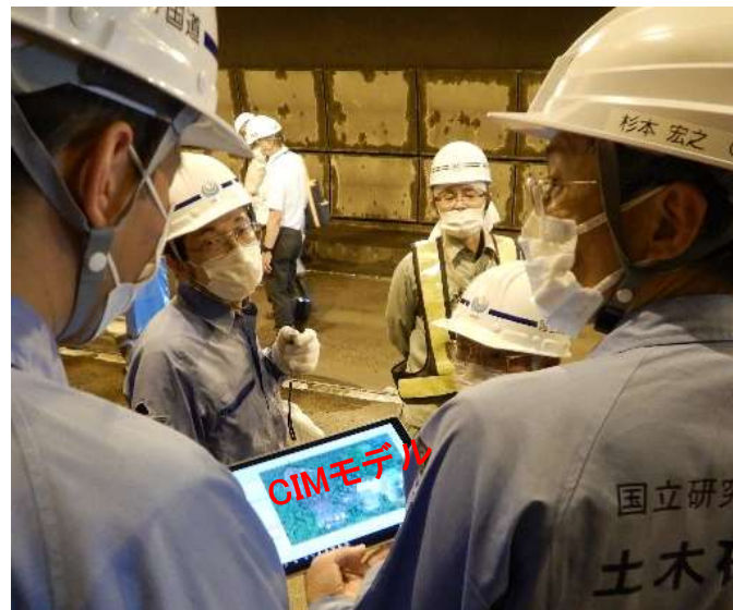
地すべりとトンネル位置の確認
