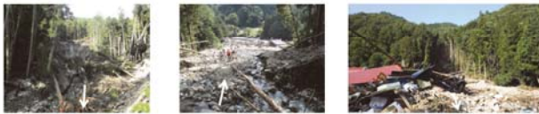
土砂発生源直下の侵食状況 溪流出口付近の土砂堆積状況 溪流出口付近での家屋被害
