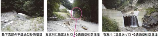
最下流部の不透過型砂防堰堤 左支川に設置されている透過型砂防堰堤 右支川に設置されている透過型砂防堰堤
