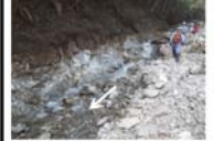
基岩の露出と表土の流出状況
