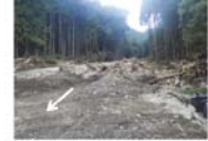
溪流出口での土砂の堆積状況
