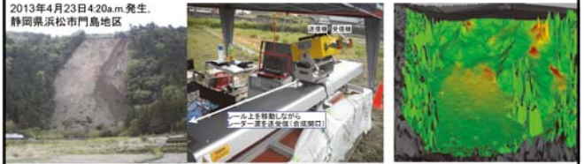
崩壊の拡大が懸念された斜面
