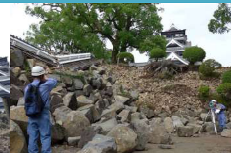
④ 崩落石材の測量
