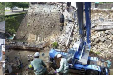
⑩ 残存石垣の解体撤去
