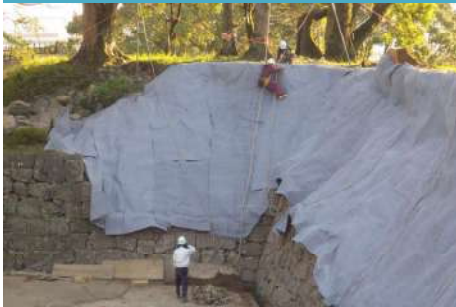
⑬ 保護シート(不織布)の設置
