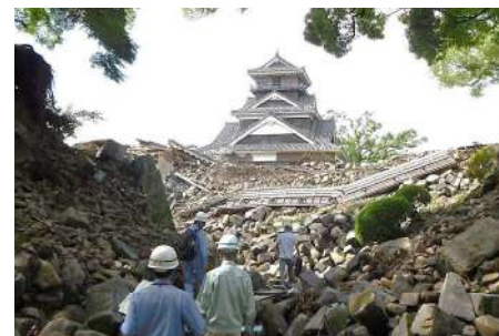
① 崩落状況の確認
