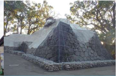
⑱ 安全対策完了
