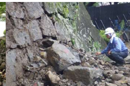
③ 崩落石材の番付
