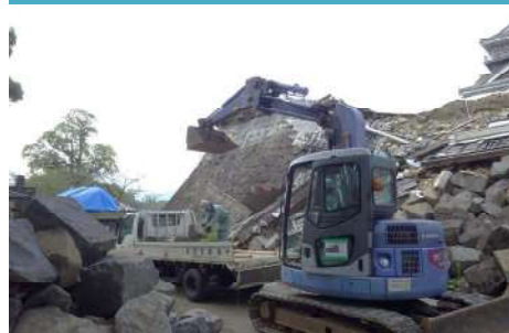
⑥ 崩落石材運搬（トラックに積み込み移動）
