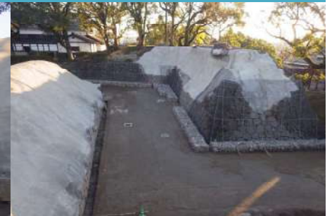
⑲ 崩落防止・安全工事完了
