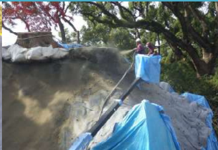
⑮ モルタル吹付け
