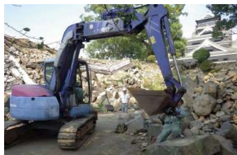
⑤ 崩落石材の撤去（1石ごと玉掛けして吊り上げ）
