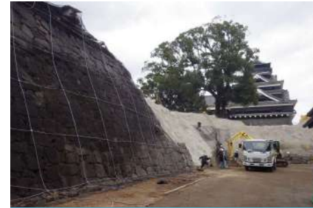
⑯ STKネット施工
