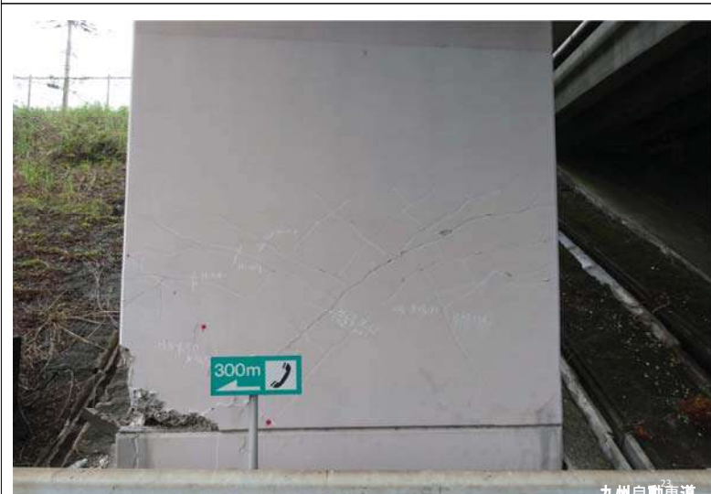
九州自動車道
