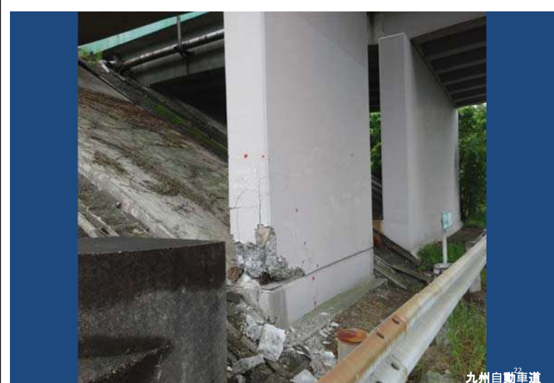
九州自動車道
