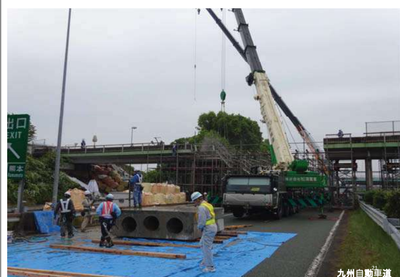
九州自動車道
