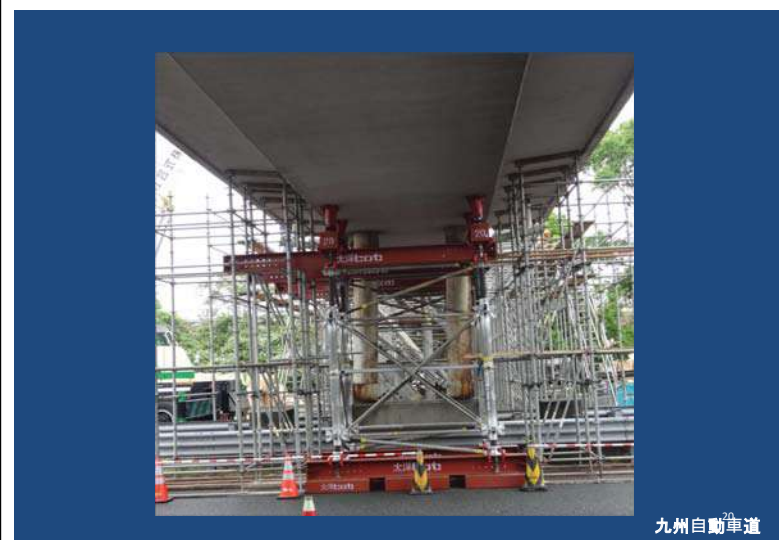
九州自動車道
