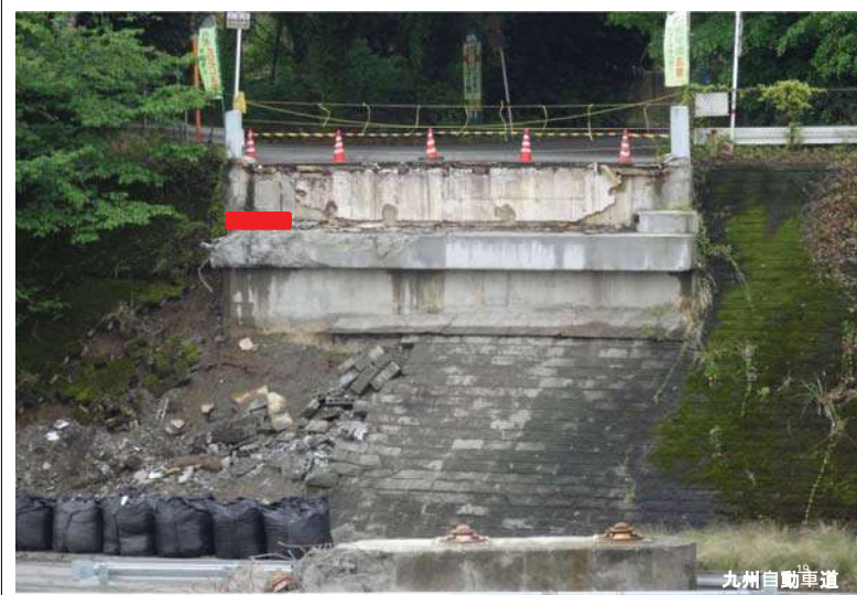
九州自動車道
