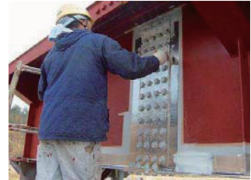
チタン箔表面にプライマーを塗付する。
