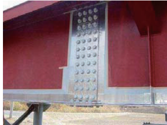
チタン箔シート貼付完了
