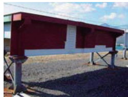
チタン用プライマー塗付後
