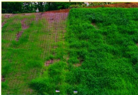
写真-1 施工1年後の緑化植生の状態 (1993年6月15日撮影)
