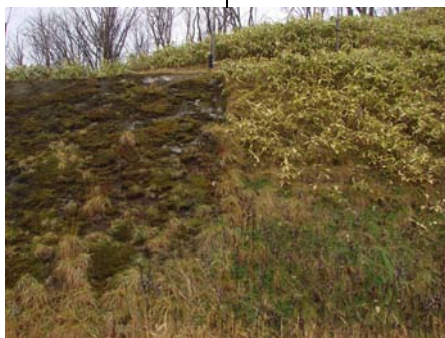
施工18年後の植生の状態
