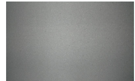
オープンブラスト素地調整後の鋼面
