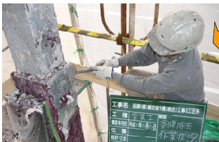
2. 塗膜除去作業 (動力工具・手工具併用による下地処理)
