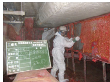
桁部 2回目塗膜除去作業
