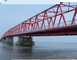
施工計画 塗装面積 16,000㎡
