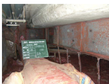
桁部 2回目はく離作業後
