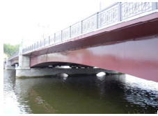
上流側 橋梁外側全径
