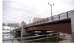
上流側の橋梁側面全景
