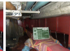
桁部 1回目はく離剤塗付け
