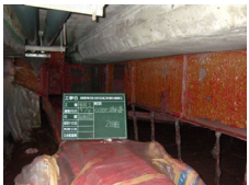
桁部 2回目塗付け 24H後
