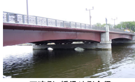
下流側 橋梁外側全径
