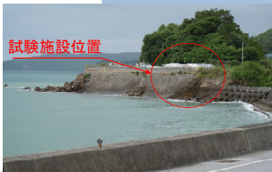
腐食環境分類: 飛来塩分が多く、厳しい腐食環境
