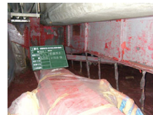
桁部 1回目はく離作業後
