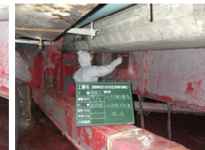
桁部 2回目はく離塗付け作業
