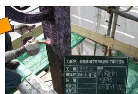
1. はく離剤の塗付け作業
