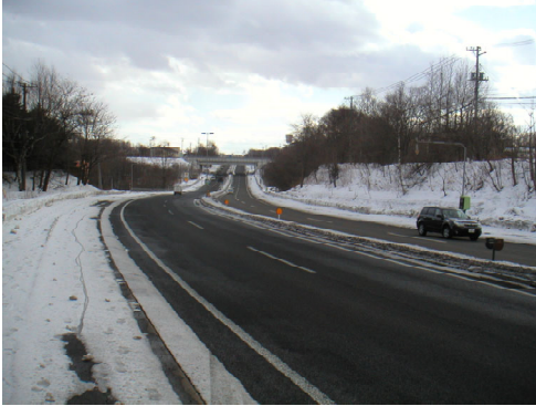
寒地土木研究所 寒地道路保全チーム
