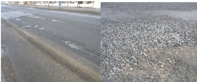
寒地土木研究所 寒地道路保全チーム
