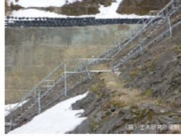
ダム下流面の状況(異常なし)
