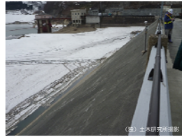
ダム上流面の状況(異常なし)
