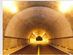
④完成 説明片側相互通行が出来ますなど
