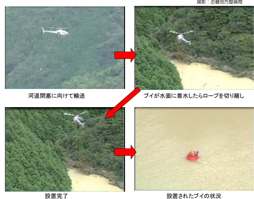
河道閉塞に向けて輸送 パイが水面に着水したらロープを切り離し 設置完了 設置されたパイの状況
