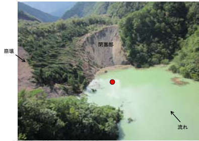
◇河道閉塞規模: 閉塞高約100m、洪水時貯水容量約750万m 3
