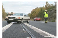
事故に対応するため、緊急車両にワイヤーロープ上を通過させる。
