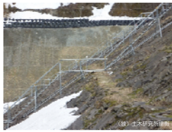
ダム下流面の状況（異常なし）
