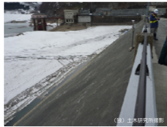
ダム上流面の状況（異常なし）
