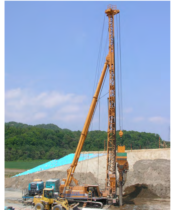
GCCP工法の施工状況
