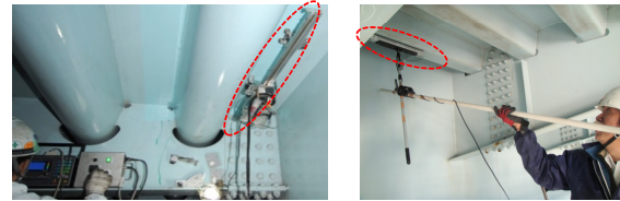
鋼床版の下側に超音波センサを設置し、調査している様子
