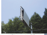
▲着雪防止シートの設置事例
