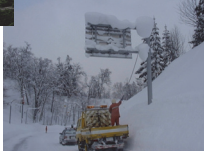
▲F型標識持面の除雪作業
