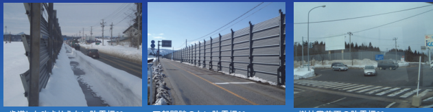
歩道しか吹き払えない防雪柵??
