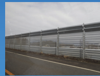
国道沿いの防雪林(福島県)
