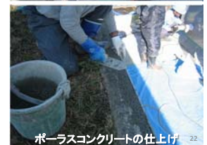
ポーラスコンクリートの仕上げ
