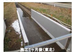
施工1ヶ月後(東北)
