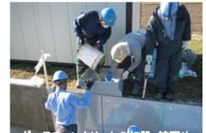
ポーラスコンクリートの打設・締固め
