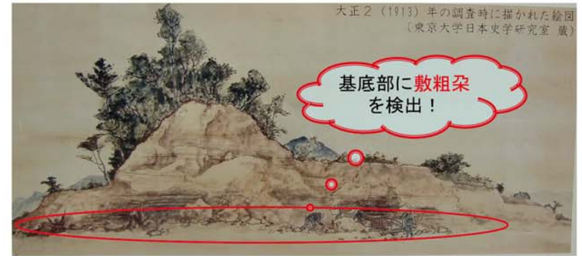
大正二年・国鉄線路敷設のため、全面開削された際のスケッチ
