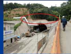
トンネル坑口
