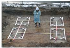
杭頭確認状況 (施工後)
